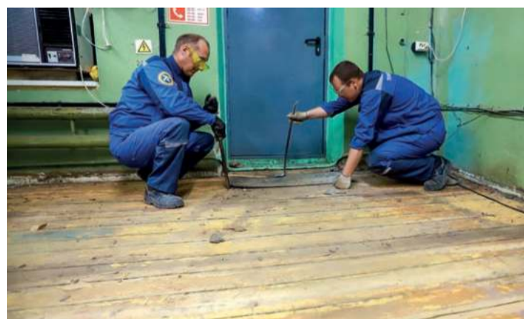
За ремонт деревянных полов в корпусе №144 цеха межцеховых коммуникаций отвечают столяры Андрей Мосунов и Юрий Козисов
